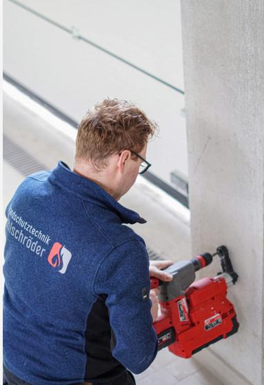
Vor der Installation wird der optimale Montageort sorgfältig ausgewählt, um eine schnelle Erreichbarkeit im Ernstfall sicherzustellen. Die Befestigung erfolgt anschließend staubarm durch direkte Absaugung beim Bohren, sodass der Arbeitsbereich sauber und ordentlich bleibt. Danach wird die Halterung präzise montiert und der Feuerlöscher sicher eingehängt.
